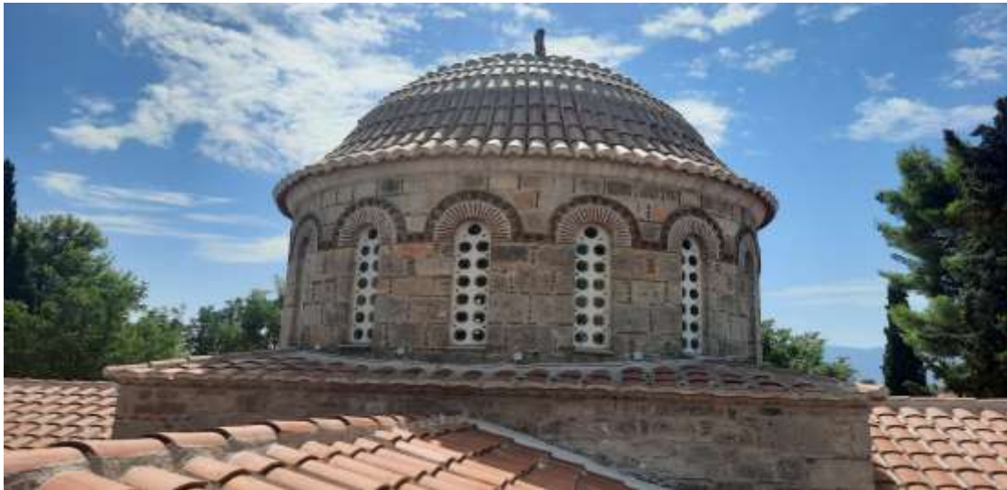
Η στέγη του ναού μετά την αποκατάσταση
