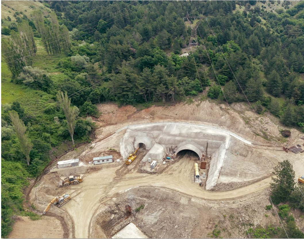
Εξωτερική άποψη σήραγγας
